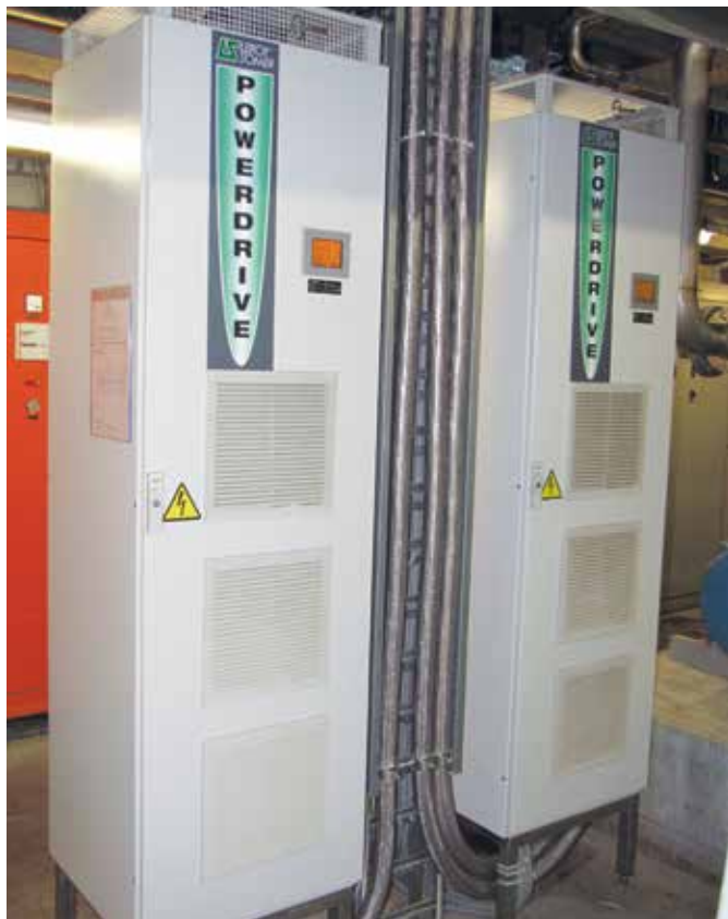
Armoire de commande avec convertisseur de fréquence
