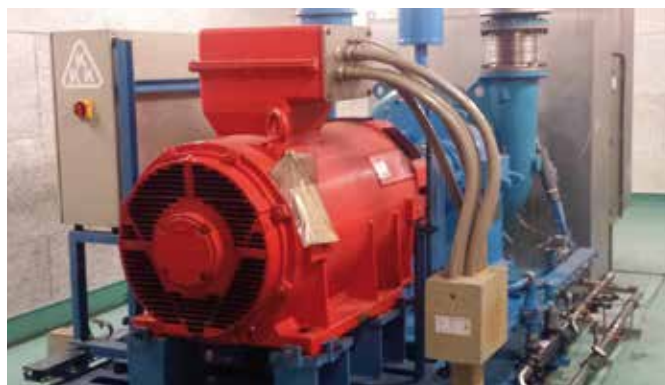
Motor und Turbokompressor auf derselben Welle
