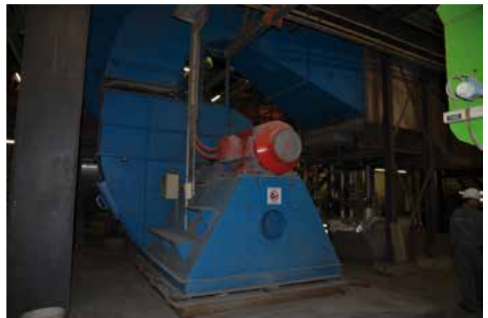
Zentrifugaler Primärluftventilator, 95 000 m 3 /h, Überdruck \Delta p von 55 mbar
