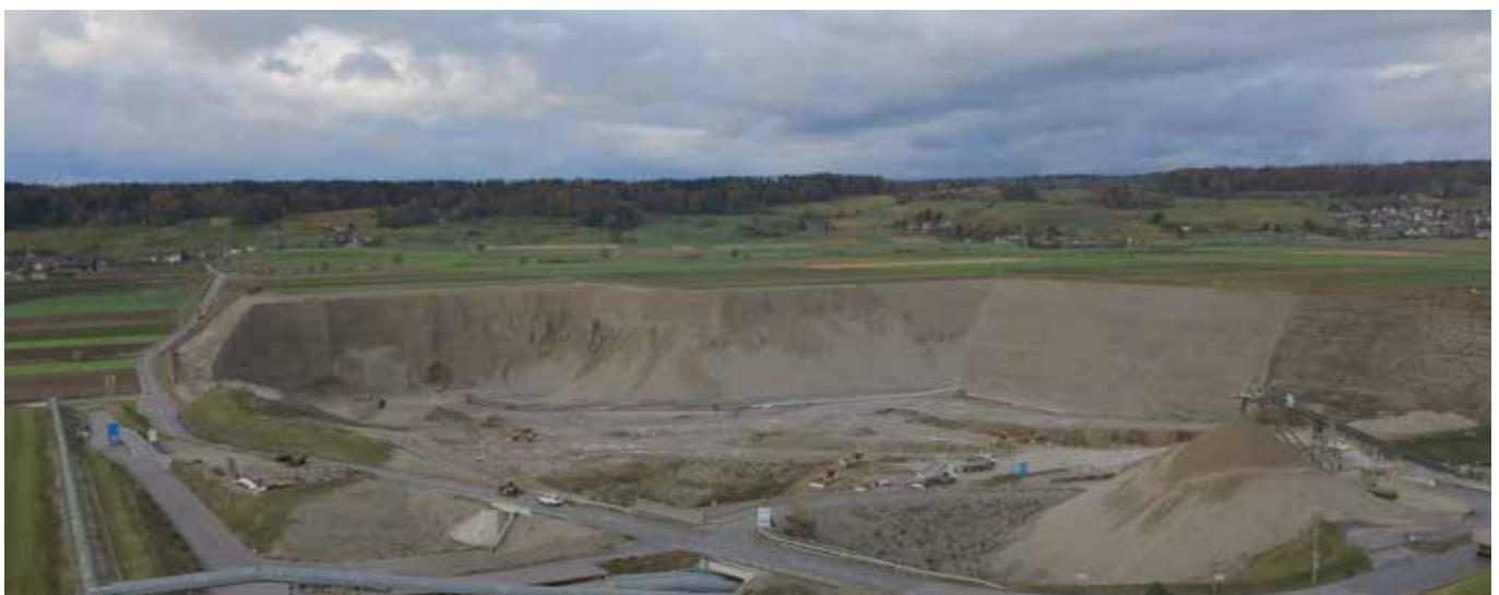
Ansicht Kiesgrube von der oberen Übergabestation aus
