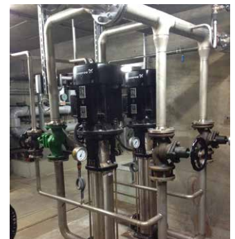
Etat avant la transformation avec des moteurs de 12,5 kW (gauche) et après avec des moteurs de 7,5 kWh (droite)
