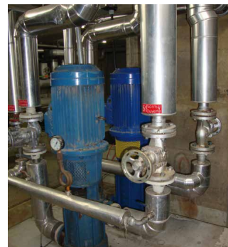
Etat avant la transformation avec des moteurs de 12,5 kW (gauche) et après avec des moteurs de 7,5 kWh (droite)
