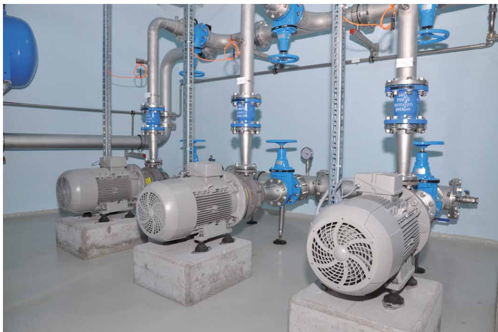
Nuovo impianto con pompe ridondanti e tubazioni rinnovate. Fotografia: Stefan Hartmann, Presseladen.
