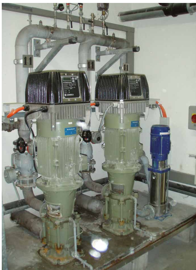
Un vecchio impianto di messa in pressione con 2 pompe Häny 4504/3 (anno di costruzione 1992) e 1 Lowara SV808 per il mantenimento della pressione (anno di costruzione 2001)
