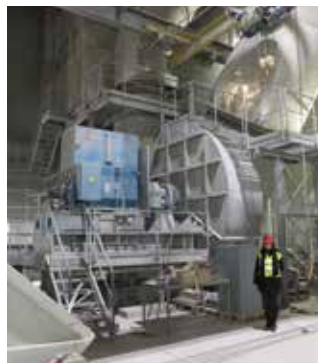
A sinistra: ventilatore dell'aria di scarico del forno prima della conversione, a destra: linea di raffreddamento del clinker prima della conversione
