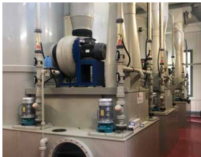
L'impianto di trattamento aria di scarico oggi. Foto: PAMP
