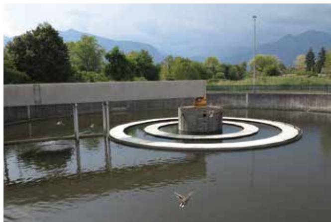
Nachklärbecken der ARA Foce Maggia. Foto: Topmotors
