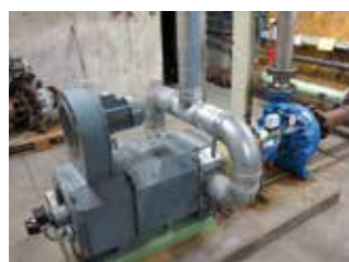
A gauche: L'ancienne pompe avec le moteur à courant continu d'origine, le refroidissement et l'aspiration. A droite: La nouvelle pompe dans son caisson. Photo: Topmotors
