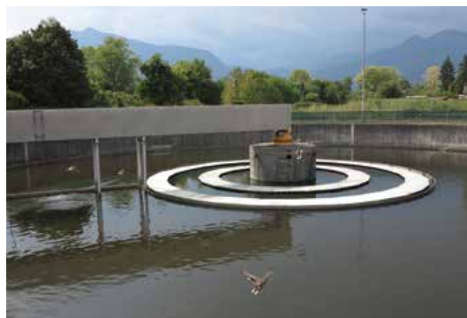
Bassin d'épuration subséquent de la STEP Foce Maggia. Photo: Topmotors
