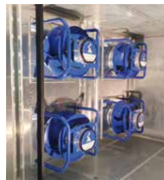
Uno dei grandi ventilatori di ricircolo d'aria prima e dopo la ristrutturazione. Foto: Lufttechnik AG Wädenswil.
