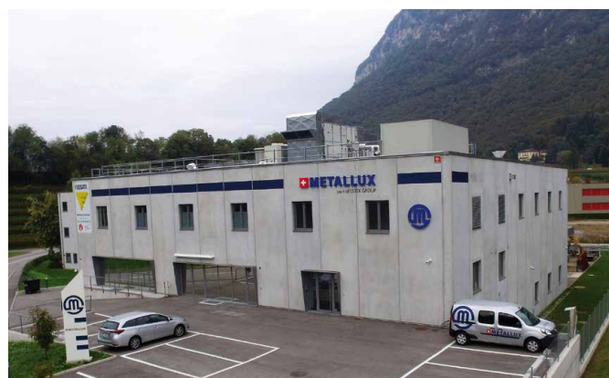
Le nouveau site de production de Metallux SA à Mendrisio. Photo: Metallux SA.
