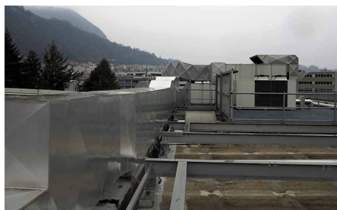
Installation de ventilation sur le toit. Photo: Márton Varga, Topmotors
